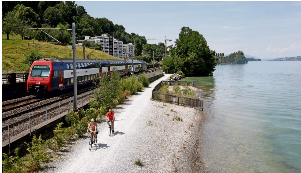
Aufgeschüttetes Land existiert bereits, wie hier am linken Seeufer zwischen Wädenswil und Richterswil. Dieses Gebiet soll als Vorbild für weitere Landaufschüttungen dienen.
